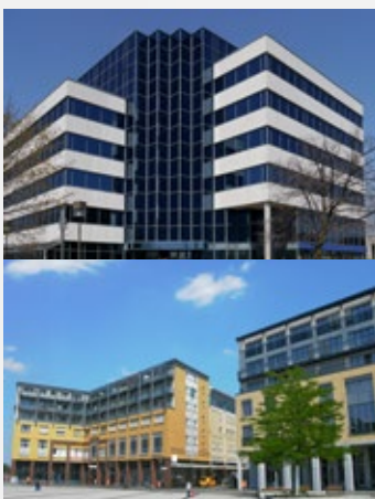
Bürogebäude, Wohn- u. Geschäftshäuser
