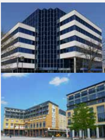
Bürogebäude, Wohn- u. Geschäftshäuser
