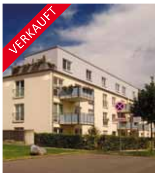
Wohnanlage 32 Einheiten, Dortmund, ca. 2.150 m 2 Wohnfläche
