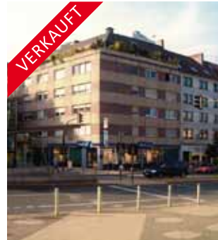
Wohn- und Geschäftshaus, Dortmund Süd, ca. 1.600 m 2 Wohn-, Büro- und Ladenfläche
