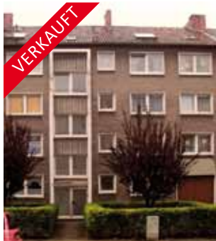
Mehrfamilienhaus, Herne, 12 Einheiten mit 810 m 2 Wohnfläche
