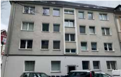
Energieeffizientes Mehrfamilienhaus in Essen-Frohnhausen
